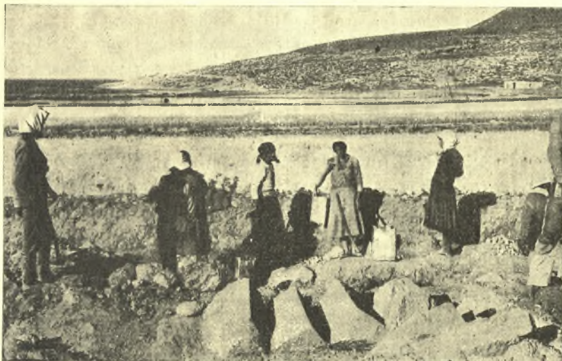
Εἰκ. 4. Ἡ καταπεσοῦσα κλίμαξ τοῦ ἄνω πατώματος κατὰ χώραν, ὡς εὐρέθη, ὀρωμένη ἐκ Δυσμῶν.
