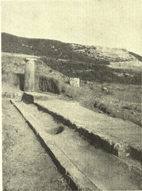
Εἰκ. 3. Τμήμα τοῦ βορείου στυλοβάτου τοῦ πειομόρφου κτηρίου μετὰ τῆς πρὸ αὐτοῦ αὐλακος.
