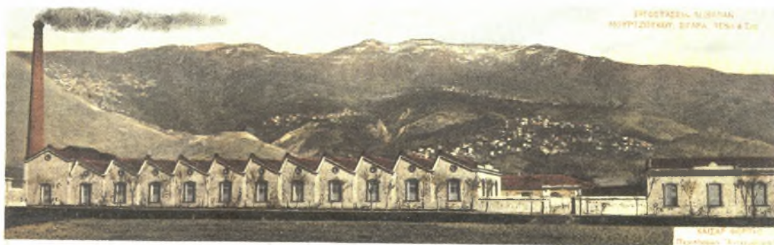
Χαρακτηριστικό δείγμα αρχιτεκτονικής εργοστασίου εποχής (οδοντωτές στέγες, μεγάλα στη σειρά ανοίγματα)
