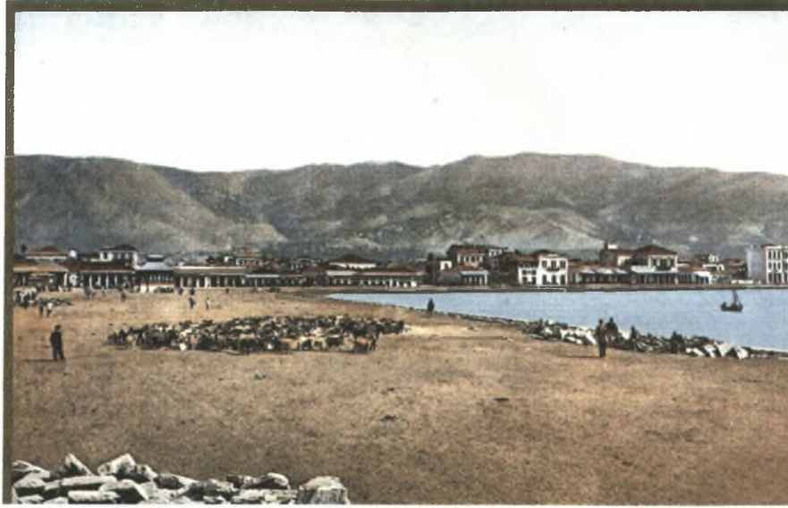
Κατασκευές λιμενικών έργων
