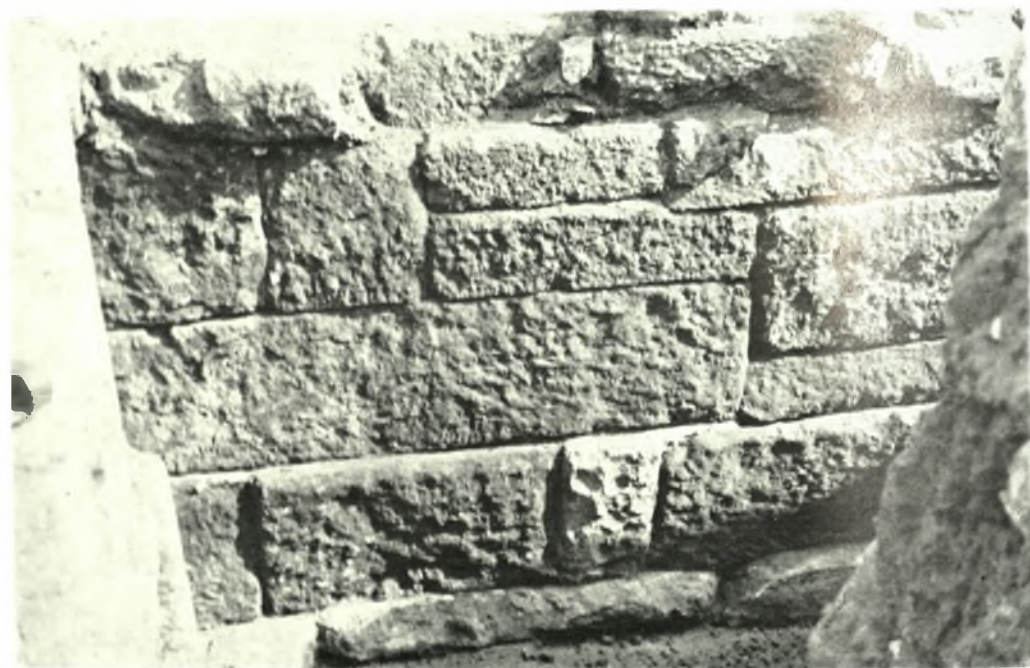
Α. Μακεδονία. Ἴλβδῆρα: α. Γωνία τοίχων κτηρίου 4ου-3ου π.Χ. αἰ., β. Λεπτομέρεια κατασκευῆς τοίχου τοῦ κτηρίου τῆς εἰκ. α.
