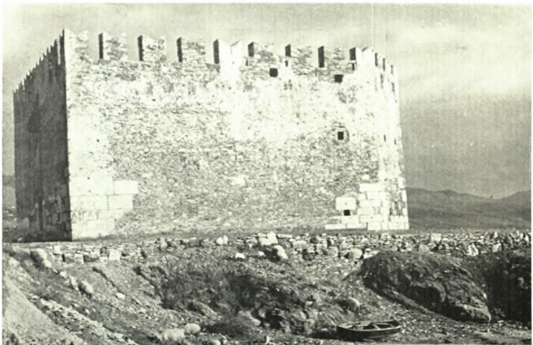
Εύβοια. Κάρυστος: α-β. Ἡ δυτική πλευρά τοῦ ὄχυροῦ Μπούρτζι πρὸ καὶ μετὰ τὴν ἐπισκευήν
