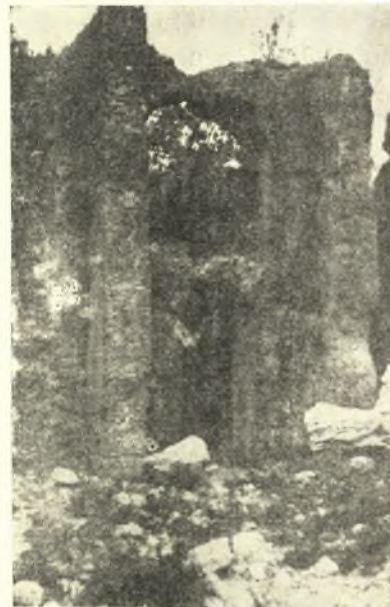
Εἰκ. 18. Ἐτερον τμήμα τῆς γεφύρας τοῦ ὕδραγωγείου, δι' ἧς διωχετεύετο τὸ ὕδωρ ἐκ τῆς ἀνατολικῆς εἰς τὴν δυτικὴν πλευρὰν τῆς χαράδρας τοῦ Λούρου.
