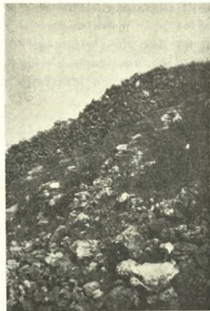
Εἰκ. 67. Κάτω ἐμπρὸς μέρος τοῦ προϊστορικοῦ τείχους, ἄνω δὲ μέρος τοῦ Ἰουστινιανείου τείχους τῆς Ἀναρράχης (Δέβρης).
