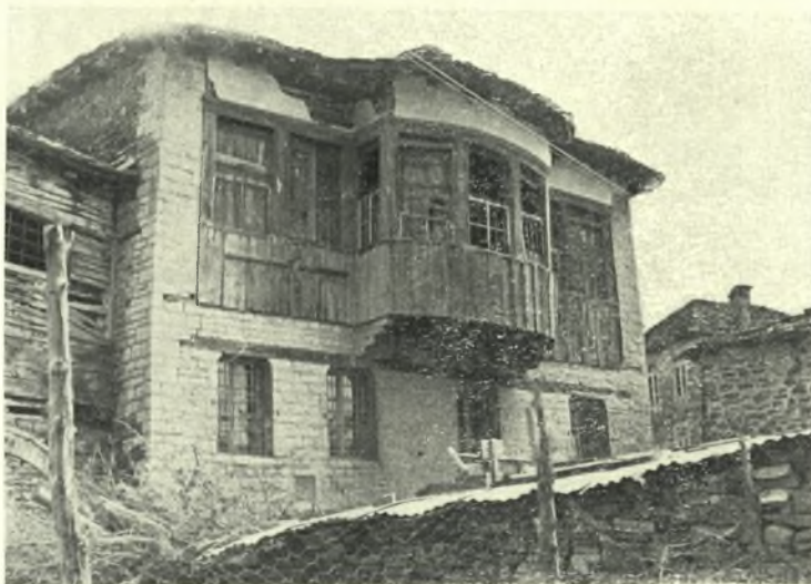
"Ηπειρος. Τσεπέλοβον: α. Έσωτερικόν οικίας Τσουμάνη, β. Ό άνακατασκευασθείς τοίχος τής οικίας Τσουμάνη, γ. Οικία Βαγγελή
