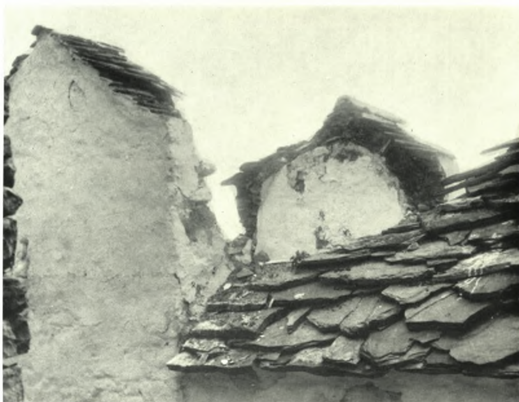
Ἄλόννησος: α. Ναὸς Ἁγίου Ἀθανασίου, β. Ναὸς Ἁγίου Δημητρίου
