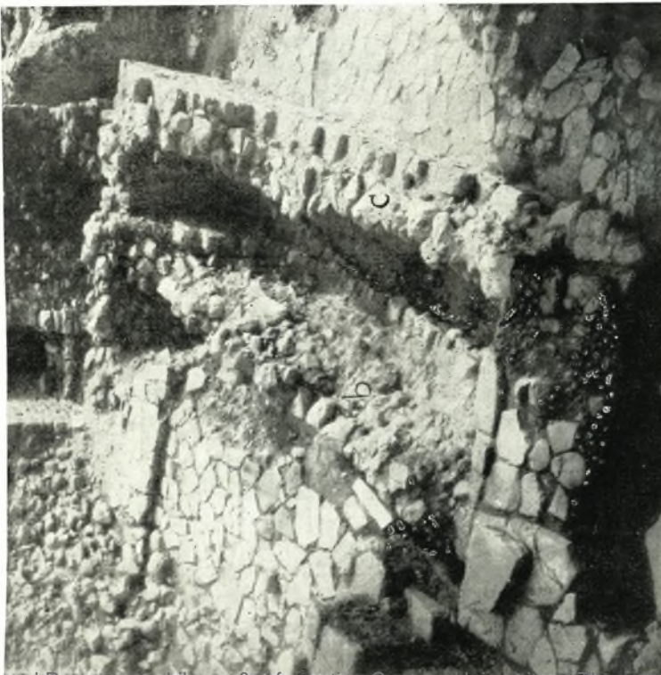
1. - La rampa, il «Bastione» (muri di sostegno) e il cortile LXX (da Ovest) (pagg. 114, 115, 117).
