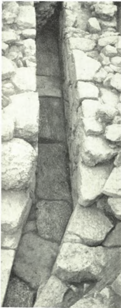
Κρήτη. Ἀρχάναι : α - β. Τμήμα τοῦ κύκλου τοῦ ὑδραγωγείου ἐσωτερικῶς εἰς ὑπόγειον οἰκίας καὶ ἐξωτερικῶς ἀπὸ Β., γ - δ. Ὁ ἀγωγὸς ἀπὸ Α. καὶ ἡ κεφαλὴ αὐτοῦ
