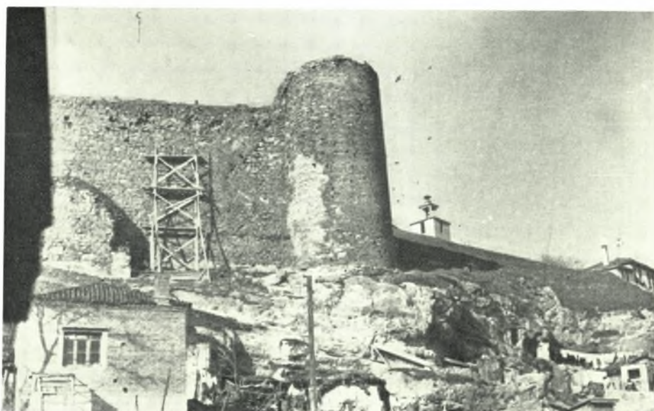
Θράκη : α. Τραιανούπολις. Σταθμός Έγνατίας οδού, β. Διδυμότειχον. Δυτική πλευρά τείχους
