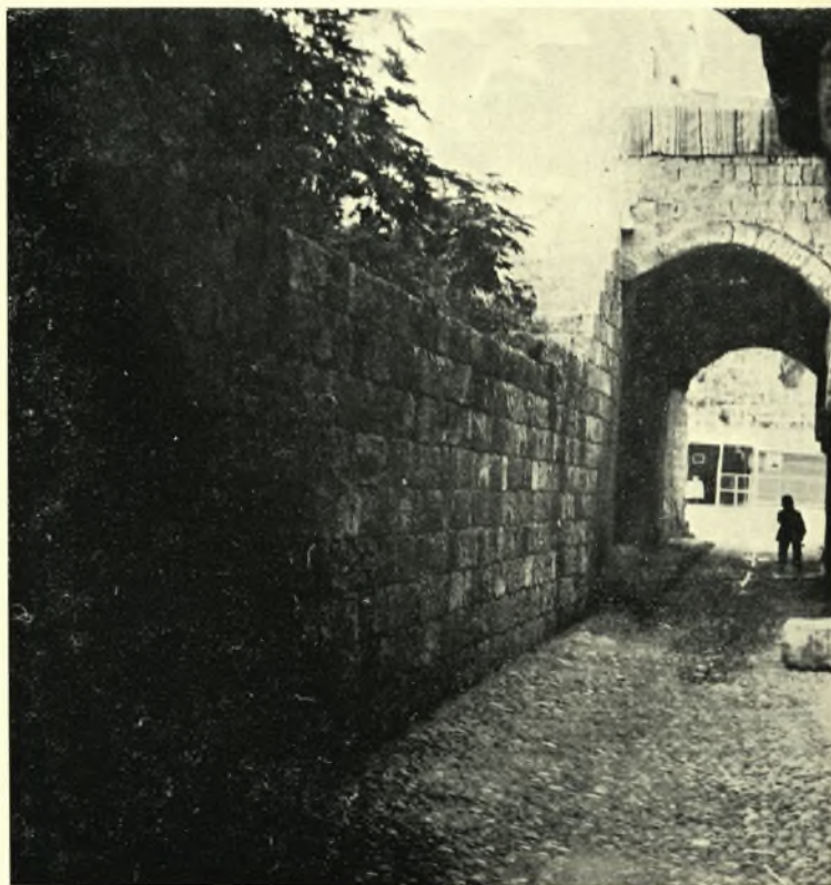
Ρόδος: α - β. Πάροδος Σοφοκλέους. Ό αναλημματικός τοίχος πρό και μετά την επίσκευήν του
