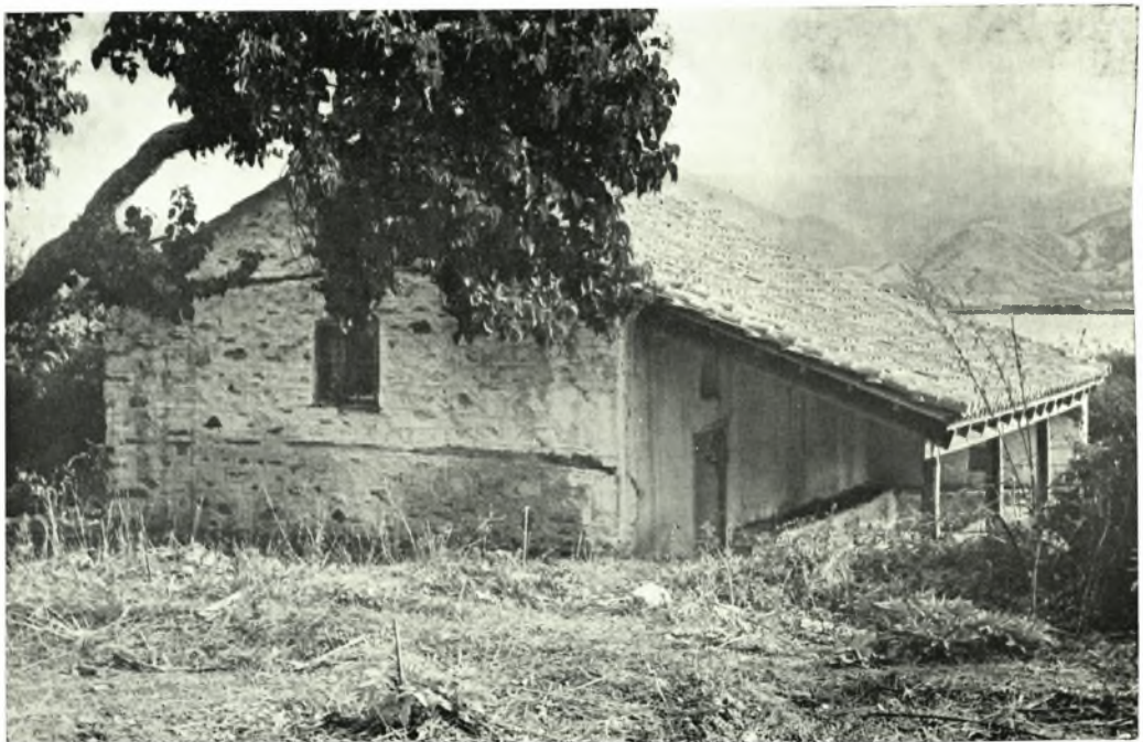
Πρέσπα: α. Ὁ ναὸς τῆς Παναγίας Πορφύρας μετὰ τὴν ἀποκατάστασιν τῆς στέγης, β. Ὁ ναὸς τοῦ Ἁγίου Γεωργίου μετὰ τὴν ἀποκατάστασιν τῆς στέγης
