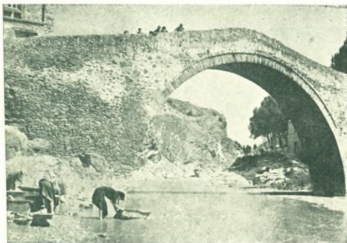
Ἐλασσών: Ἡ μεγάλη μονότοξος γέφυρα τῆς κωμοπόλεως
