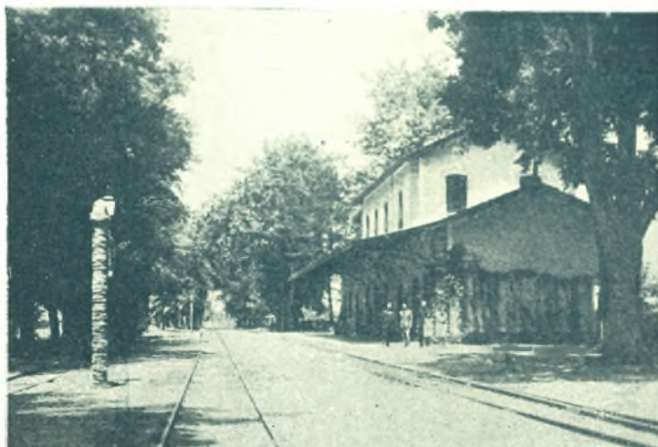
Τρίκαλα: Ὁ Σταθμὸς τῶν Θεσσαλικῶν Σιδηροδρόμων
