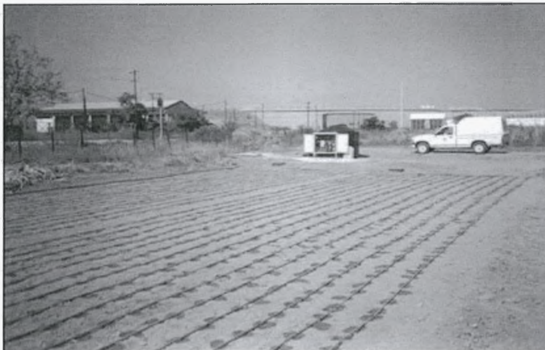
Εικόνα 2.5 Έλεγχος λειτουργίας του αρδευτικού συστήματος
