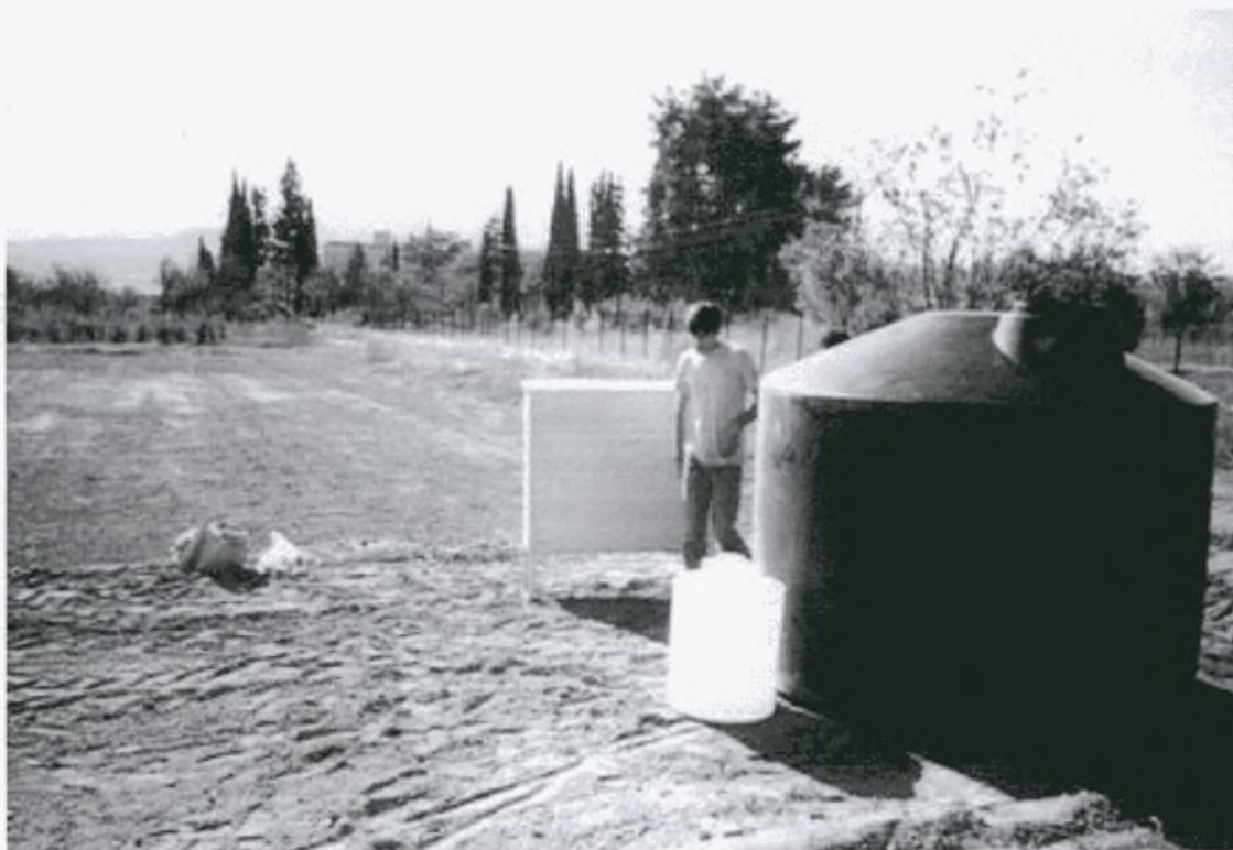
Εικόνα 2.2 Τοποθέτηση της πλαστικής δεξαμενής
