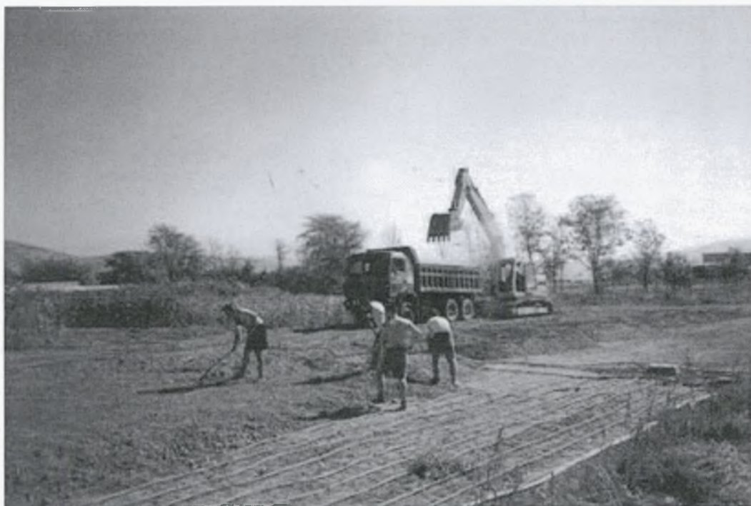
Εικόνα 2.6 Επιχωμάτωση και ισοπέδωση του πειραματικού αγρού
