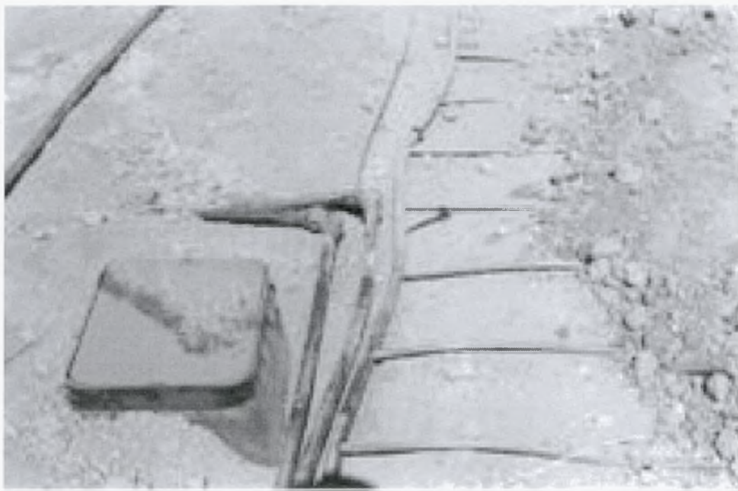
Εικόνα 2.4 Σύνδεση των αγωγών μεταφοράς με τους σταλακτηφόρους
