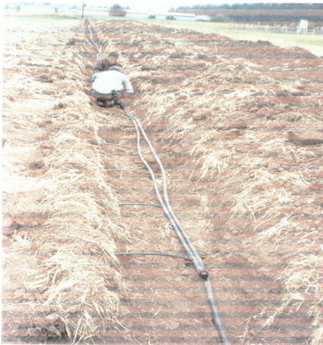
Εικόνα 11. Τοποθέτηση υπόγειας στάγδην άρδευσης
