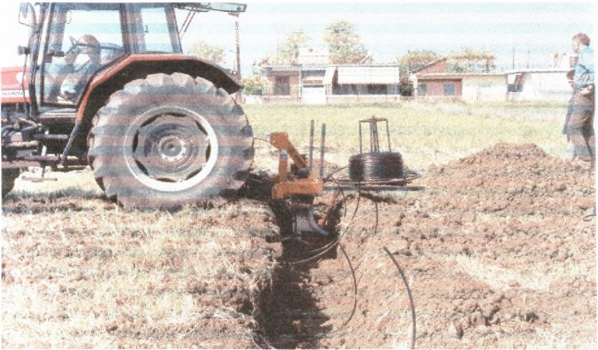
Εικόνα 9. Τοποθέτηση υπόγειας στάγδην άρδευσης
