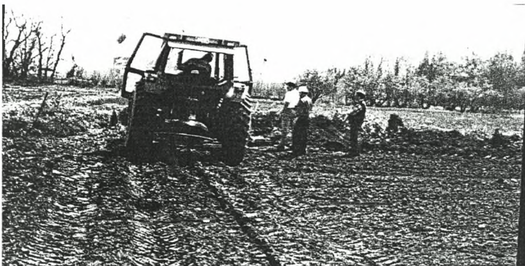
Εικόνα 5.1. Τοποθέτηση υποεπιφανειακού σταλακτηφόρου σωλήνα
