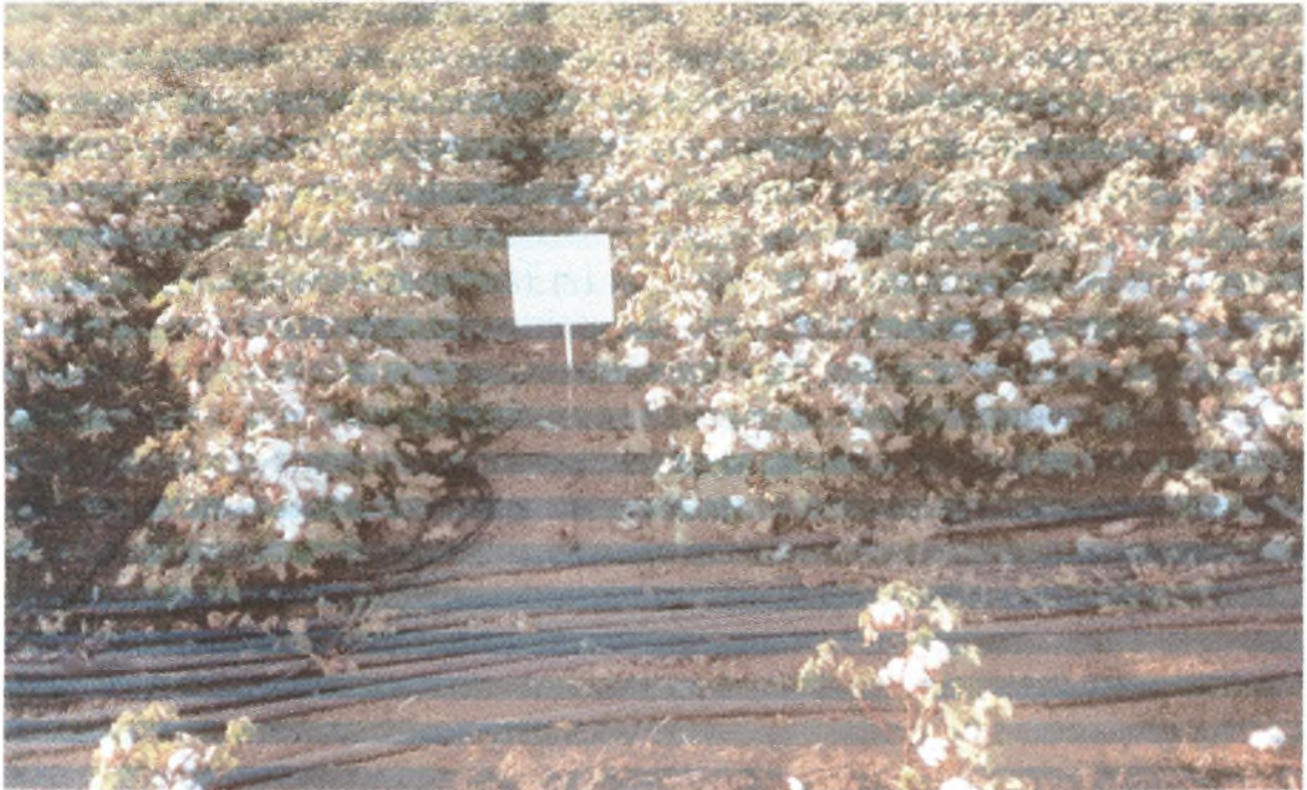
Εικόνα 10. Δευτερεύοντες αγωγοί συστήματος στάγδην άρδευσης
