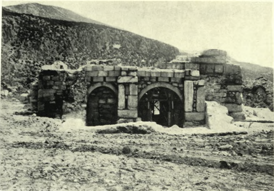
Ἀντίκυρα: α. Τὰ ἔρειπια τοῦ ἀποκαλυφθέντος εἰς σχῆμα σταυροῦ Πύργου ἀπὸ Β., β. Τὸ κτίσμα ἀπὸ Β. μετὰ τὴν διάλυσιν τῆς βορείου κεραίας τοῦ Πύργου
