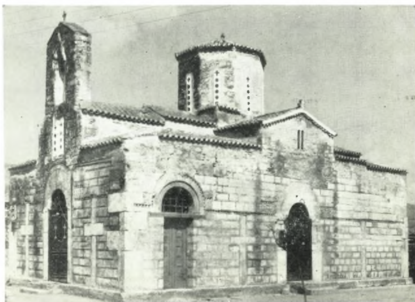
β. Ὁ νὰὸς τοῦ Χώνικκ μετὰ τὴν ἀποκατάστασιν τῆς πλαγίας θύρας τοῦ νάρθηκος αὐτοῦ.
