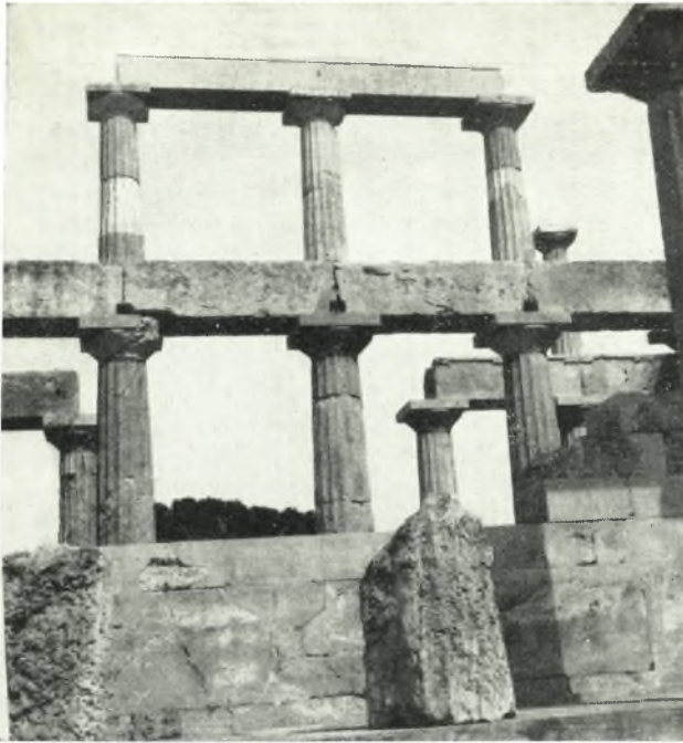
α. Αί ἐπάλληλοι κιονοστοιχίαι τοῦ σήκου τοῦ ναοῦ τῆς Ἀφροδίτης μετὰ τὴν τοποθέτησιν τοῦ ἄνω ἐπιστυλίου αὐτοῦ.
