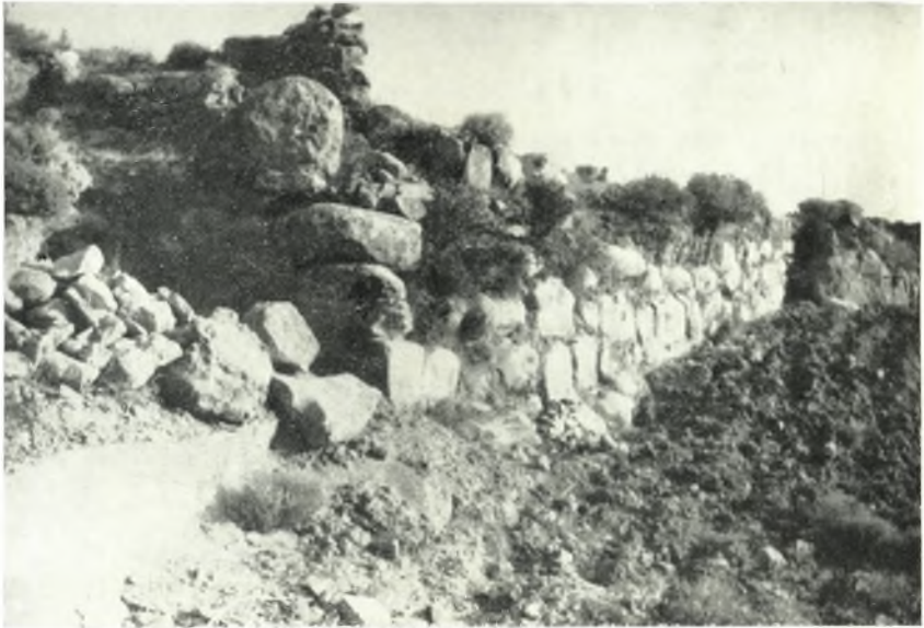
α. Μινωικόν κτήριον εἰς θέσιν Φλέγα Τουρτούλων.
