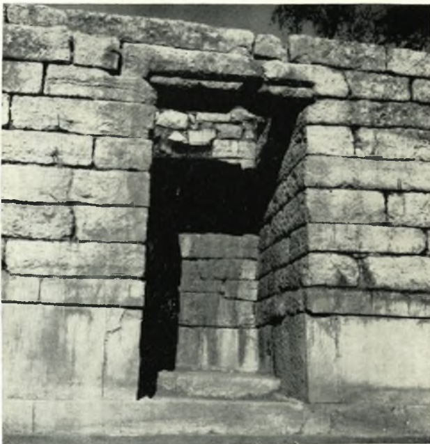
β. Ἡ ὑπὸ τὸ Σεβάστειον πυλῖς μετὰ τὴν τελείαν ἀποκάλυψιν αὐτῆς καὶ τὴν ἀποκατάστασιν τοῦ ὑπερθύρου της.
