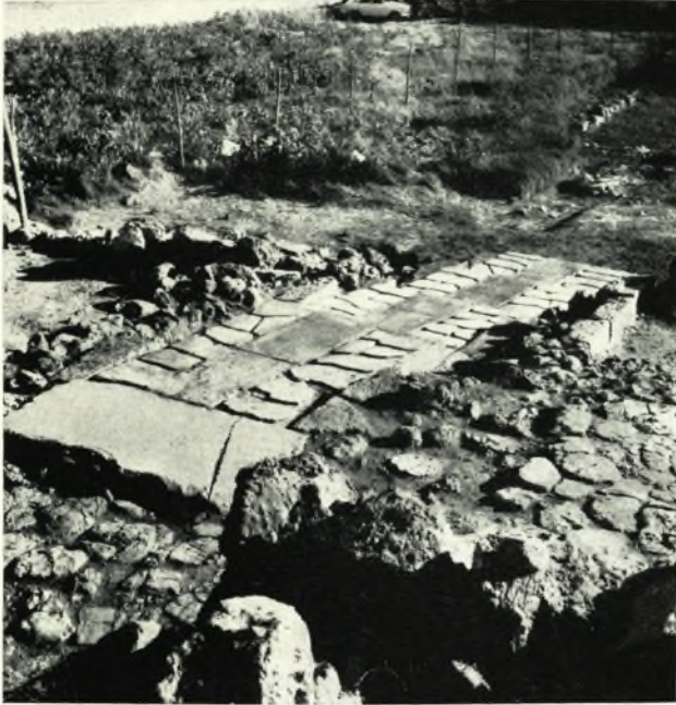
α. Ἡ κυρία ΒΑ. πύλη τοῦ Ἀνακτόρου τῆς Ζάκρου μετὰ τὴν ἀποκατάστασίν της, ἀπὸ Β.
