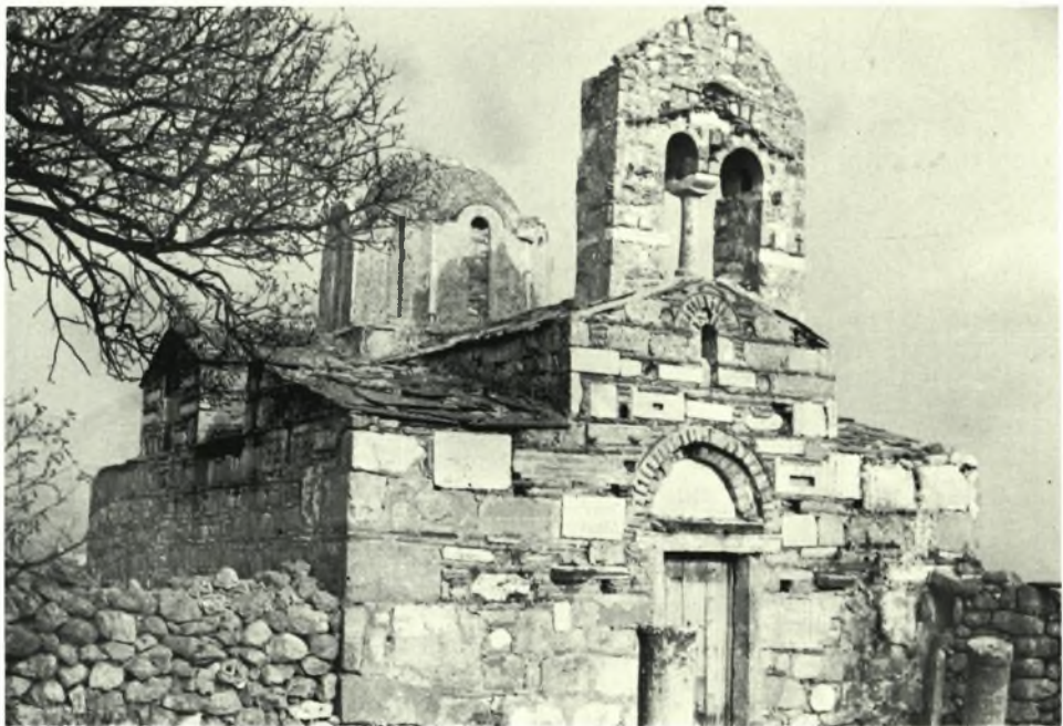
Μάνη : α. Σωτήρ Γαρδενίτσης μετά τὰς ἐργασίας, β. Ἅγιος Ἰωάννης Κέριας
