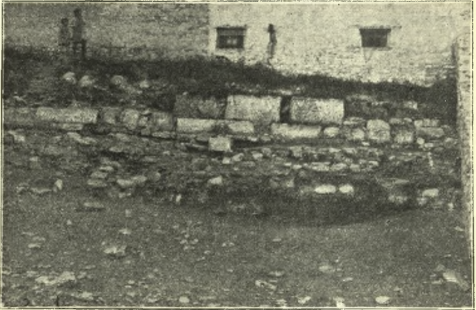
Εἰκ. 1. Θεμέλια δυτικῆς πλευρᾶς τοῦ φρουρίου Βόλου.
