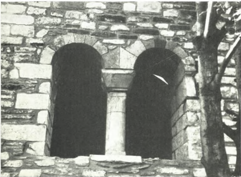
β. Τὸ ἀνοιχθὲν κατὰ τὴν βόρειον πλευρὰν τοῦ Ἁγ. Νικολάου δίλοβον παράθυρον μετὰ τὰς ἐργασίας ἀποκαταστάσεως αὐτοῦ.
