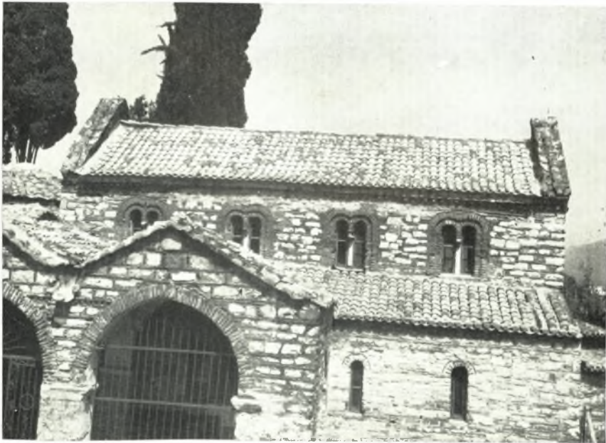
β. Ἡ νέα κατασκευασθεῖσα στέγη τῆς Ἁγ. Θεοδώρας.
