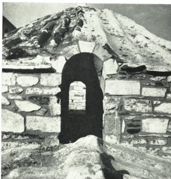
β. Τὸ βόρειον παράθυρον τοῦ τετραγώνου τρούλλου τοῦ Ἁγ. Νικολάου μετὰ τὰς ἐργασίας ἀποκαταστάσεως αὐτοῦ.
