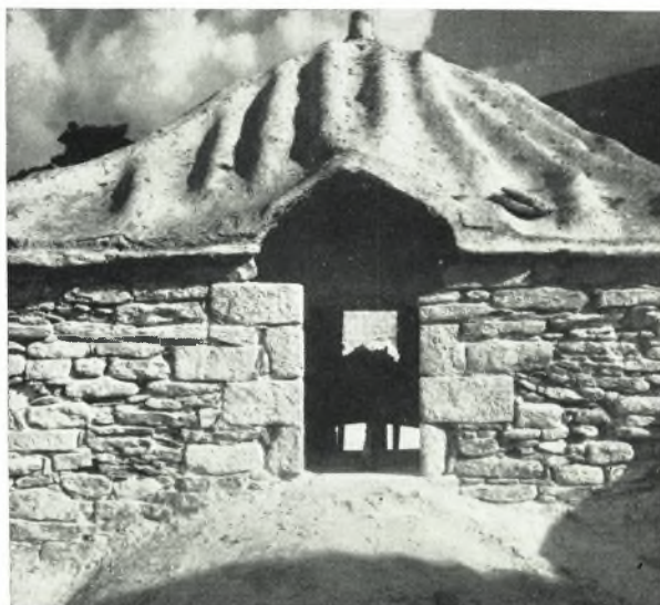
α. Τὸ βόρειον παράθυρον τοῦ τετραγώνου τρούλλου τοῦ Ἁγ. Νικολάου πρὸ τῶν ἐργασιῶν ἀποκαταστάσεως αὐτοῦ.
