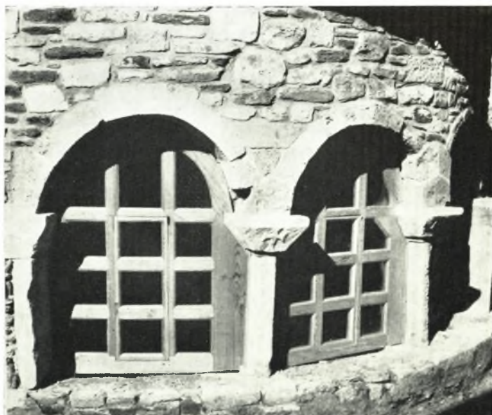
β. Τὸ τρίλοβον παράθυρον τῆς ἀψίδος τοῦ 'Αγ. Νικολάου' μετὰ τὰς ἐργασίας ἀποκαταστάσεως αὐτοῦ.
