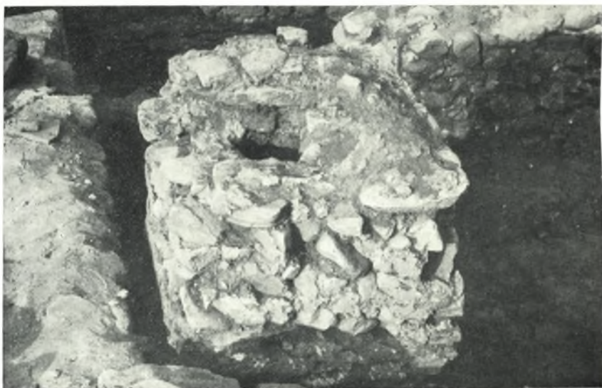
β. Τὸ κατώτατον τμήμα κτιστῆς καπιτοδόχης εἰς διαμέρισμα ΒΑ. τοῦ Ὀκταγώνου.
