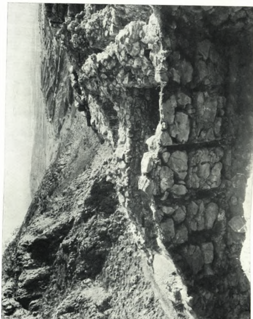
Ξυλοδεστιά βορείας όψευς του τοίχου «α» (Φωτογραφία Δ. Α. Χαριστιάδου).
