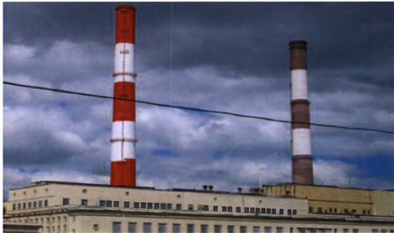
Εικόνα 13:Εργοστάσιο τηλεθέρμανσης στην Μόσχα
