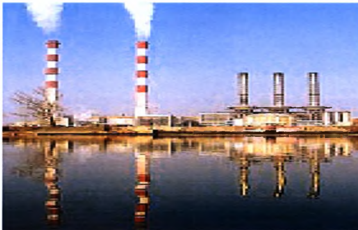
Εικόνα 14:Εργοστάσιο τηλεθέρμανσης στο Βελιγράδι
