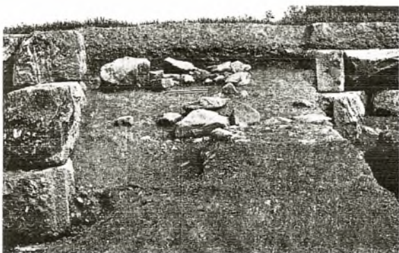
89. Φερές. Η πύλη του τείχους στο λόφο του «Αγίου Αθανασίου»
