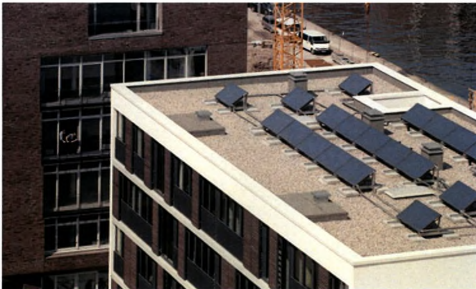
Εικόνα 10. Ηλιακοί συσσωρευτές στην οροφή κτιρίου. (πηγή : www.hafencity.com )
