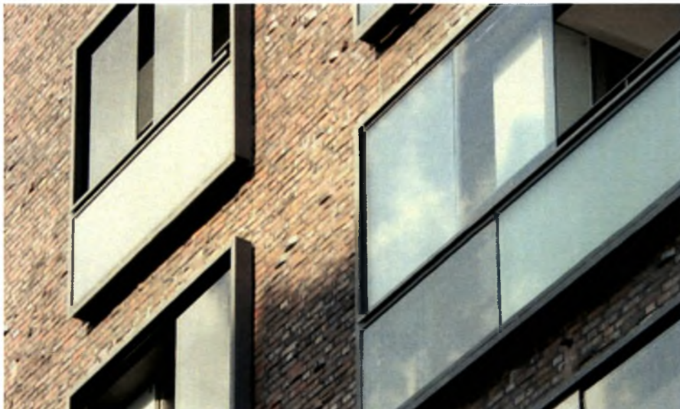
Εικόνα 11. Κατασκευή σύγχρονου κουφώματος. (πηγή : www.hafencity.com )
