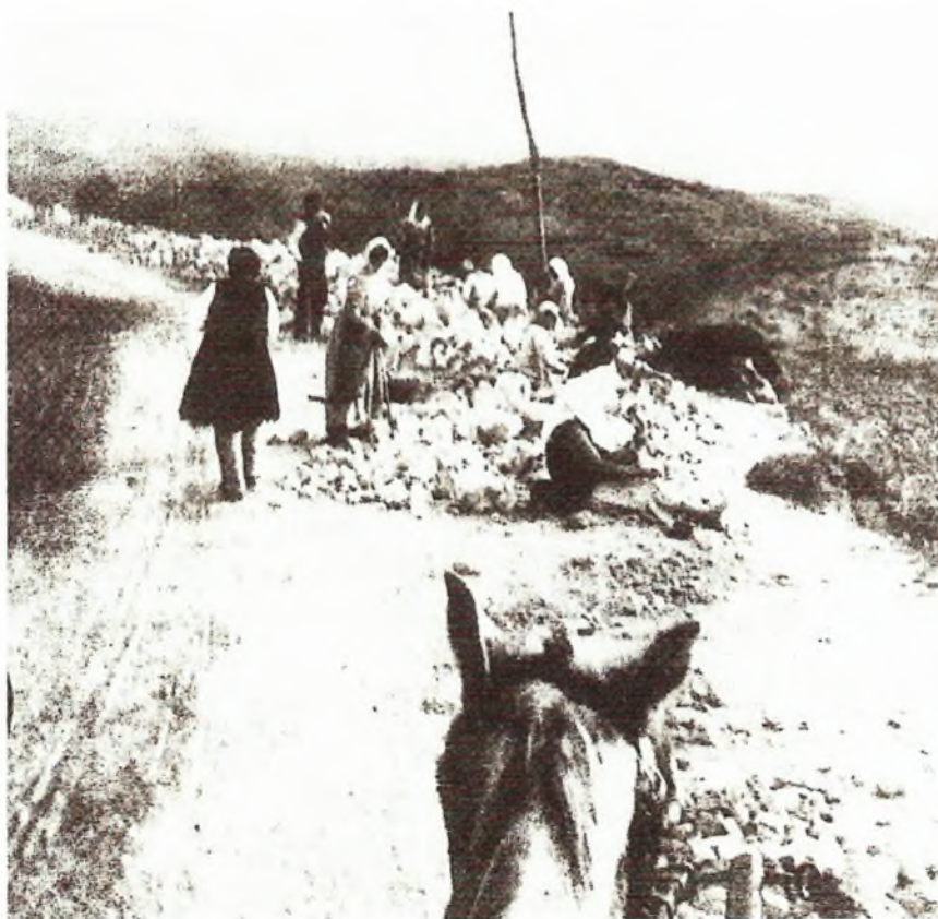
Σκυρόστρωση της σιδηροδρομικής γραμμής στο χωριό από τις «ομάδες» των κατοίκων. Τις πέτρες που έσπαζαν τις μετέφεραν με κάρα (Σπάνια φωτογραφία του 1902).
