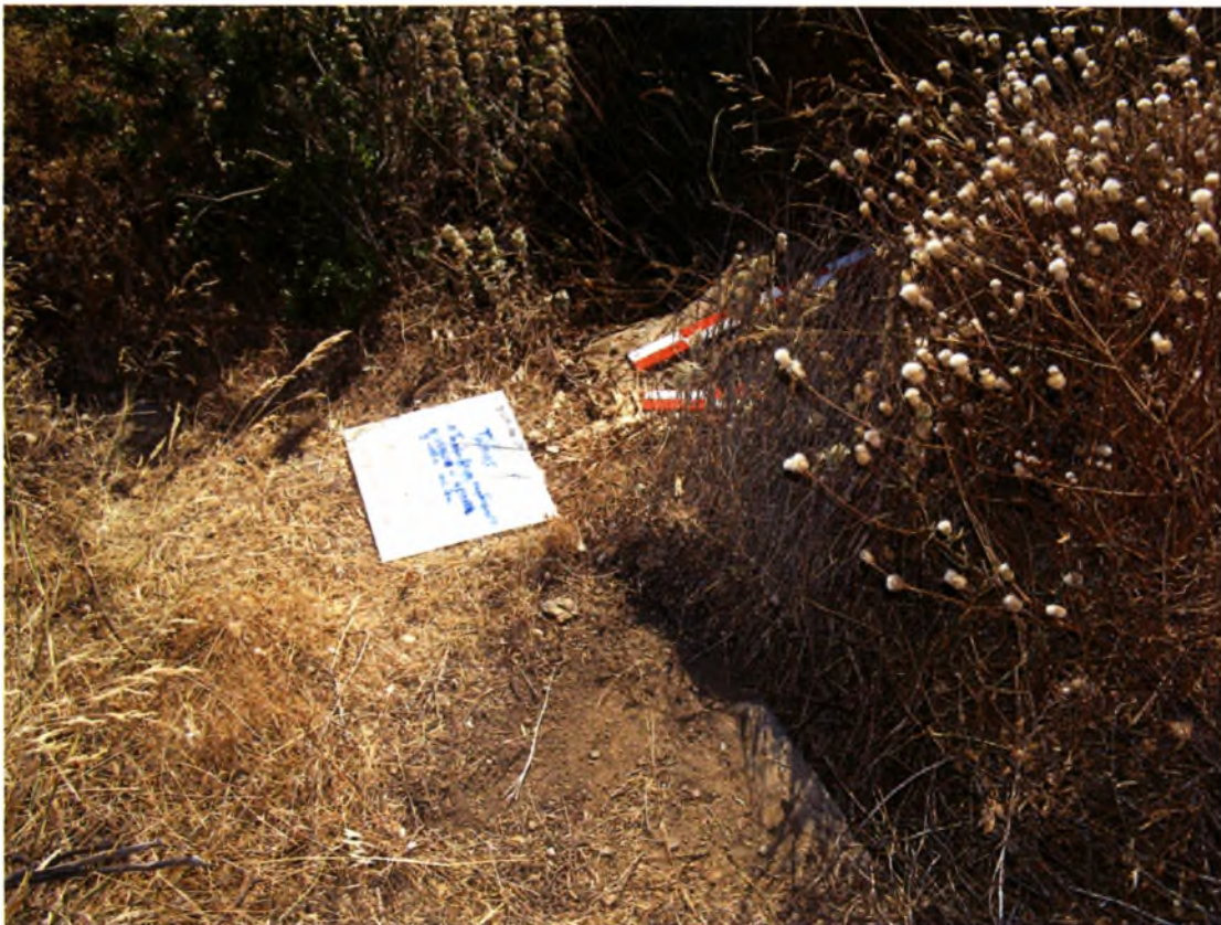
Εικ. 30: Κατεστραμμένο τμήμα αύλακας κοντά στη «φρεατία»
