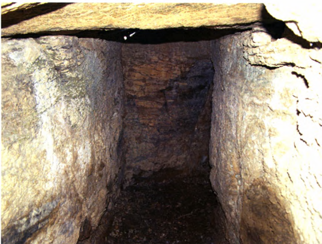
Εικ. 42: εσωτερικό διπλής καμπής. Λήψη από ΝΔ
