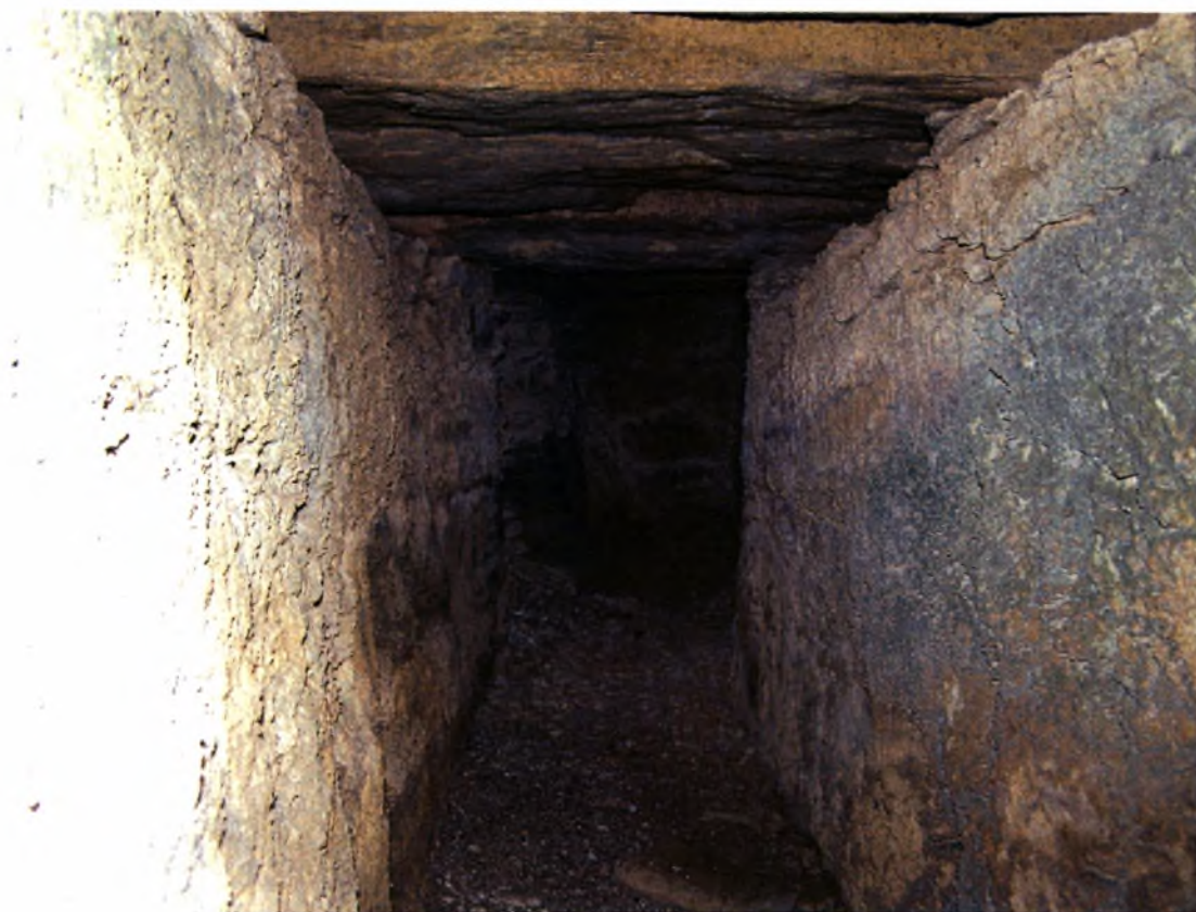
Εικ. 43: εσωτερικό διπλής καμπής. Λήψη από ΒΑ
