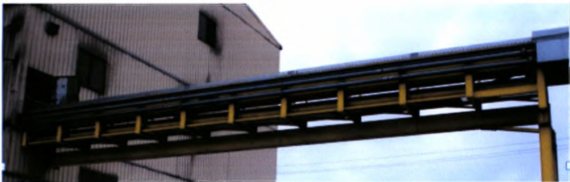
Εικόνα 4.2 Ενδεικτική μεταλλική κατασκευή προστασίας
