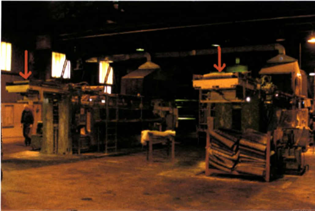
Εικόνα 4.1 Έξοδος Ζυμωτηρίου όπου θα τοποθετηθεί η νέα διάταξη
