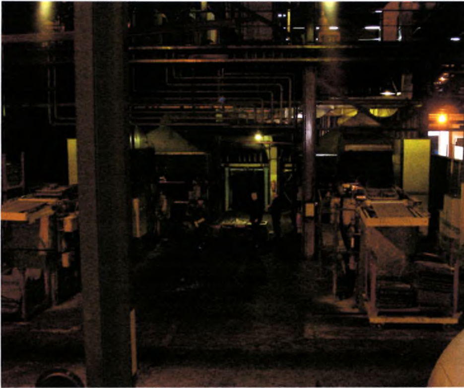
Εικόνα 3.1: Χώρος παλιού Ζυμωτηρίου
