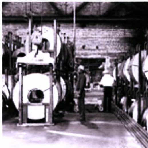
Εικόνα 4.13 Εφαρμογή διάταξης σε βιομηχανικό χώρο
