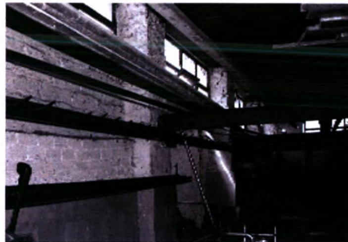
εικ16/ Πίσω πλευρά κτιρίου σφαγείων, προς δυτική μεριά
