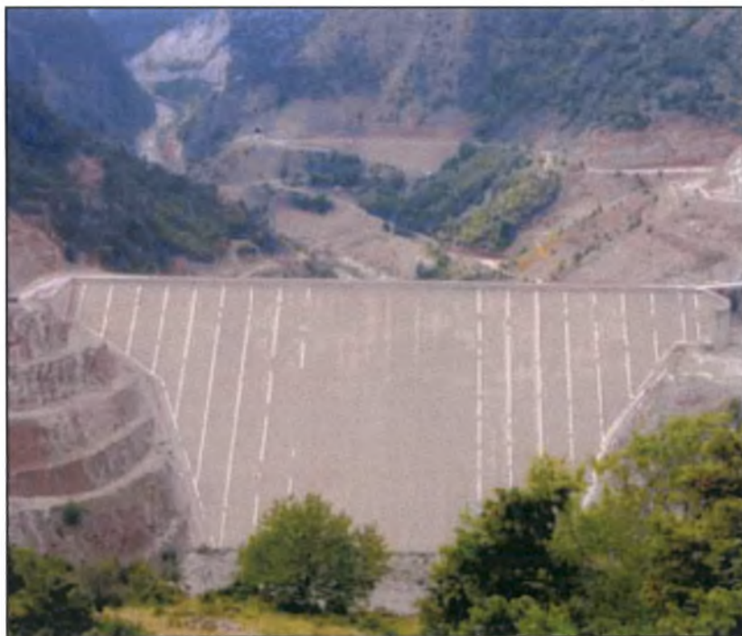
Σχήμα 5.1: Άποψη του φράγματος της Μεσοχώρας, μετά την ολοκλήρωση της κατασκευής του (Dakoulas, 2007).
