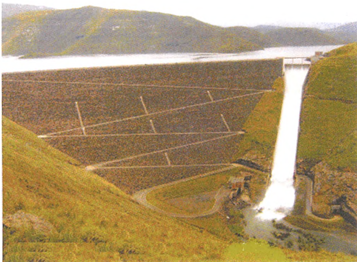
Σχ.2.12: Η υπερχείλιση του Mohale μετά τις πλημμύρες.
