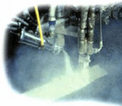
Εικόνα1.30: Εφαρμογή θερμοπλαστικής διαγράμμισης με ψεκασμό. Διακρίνεται και η διασπορά των γυάλινων σφαιριδίων.
