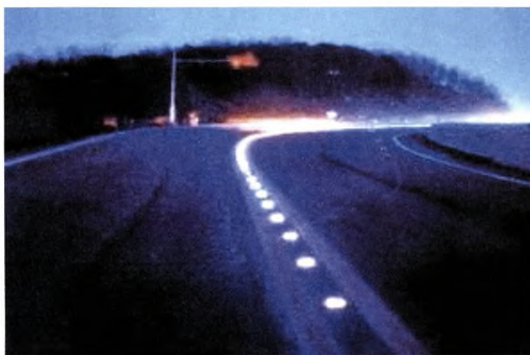
Εικόνα 1.34: Ανακλαστήρας οδοστρώματος
