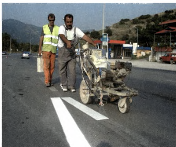
Εικόνα 1.25 & 1.26: Τεχνική διάστρωσης σφαιριδίων
