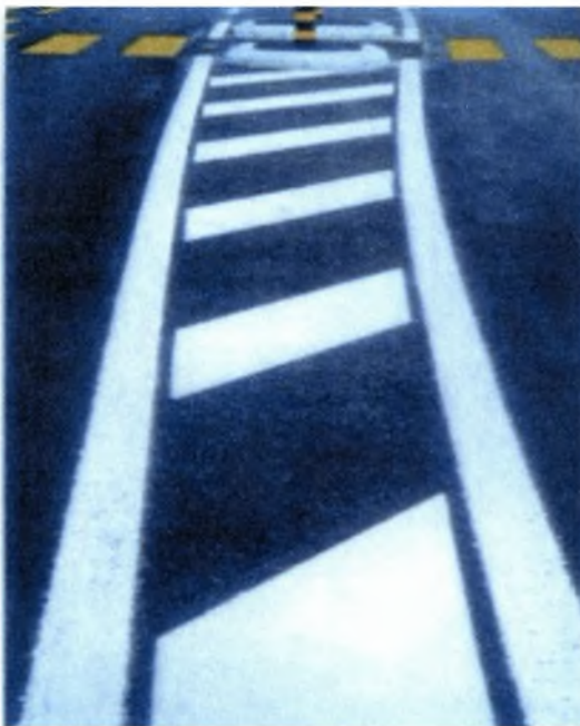
Εικόνα 1.31: Ανάγλυφη ψυχροπλαστική διαγράμμιση δύο συστατικών
