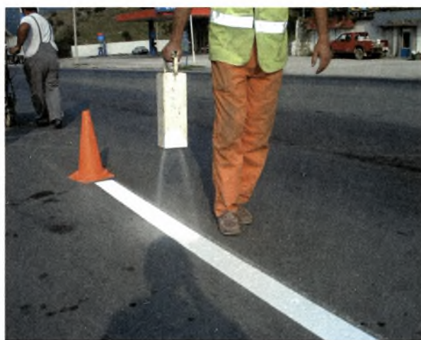
Εικόνα 1.25 & 1.26: Τεχνική διάστρωσης σφαιριδίων
