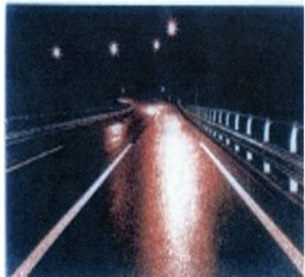
Εικόνα 1.31: Ανάγλυφη ψυχροπλαστική διαγράμμιση δύο συστατικών
