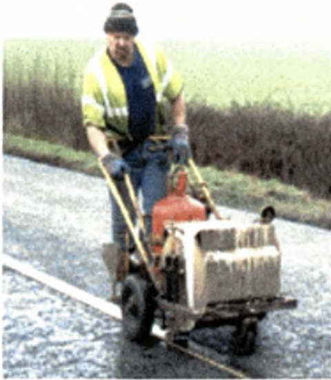
Εικόνα 1.27: Χειροκίνητος μηχανισμός έγχυσης θερμοπλαστικού υλικού.
