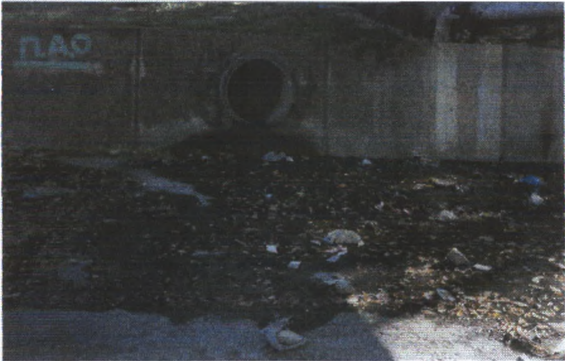
Φωτο. 4, 5, 6: Απεικόνιση οχετών όμβριων υδάτων διαμέτρου 200 mm, 300 mm, 750 mm αντίστοιχα
