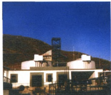
Εικόνα 2.6 κτίριο παραγωγής ενέργειας
