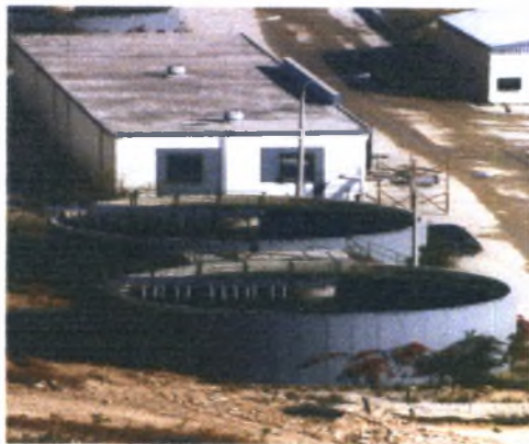
Εικόνα 2.1. Δεξαμενές προπάχυνσης της ΜΕΥΑ Βόλου.
