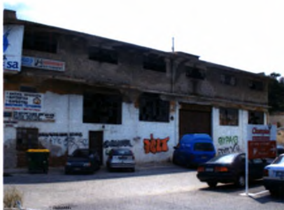
Εικόνες 6.5, 6.6, 6.7 και 6.8: Κατάσταση Κτιρίων
