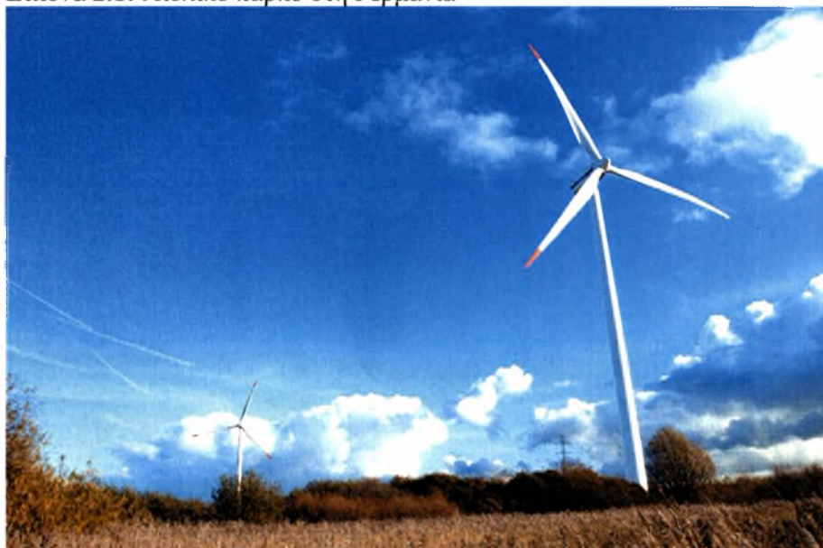
Εικόνα 2.1: Αιολικό πάρκο στη Γερμανία
