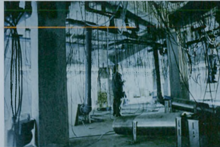
Εικόνα 15 Μηχανολογικός και ηλεκτρολογικός μηχανισμός του "Γλυπτού Ποταμού" © Προσωπικό αρχείο Νέλλας Γκόλαντα
