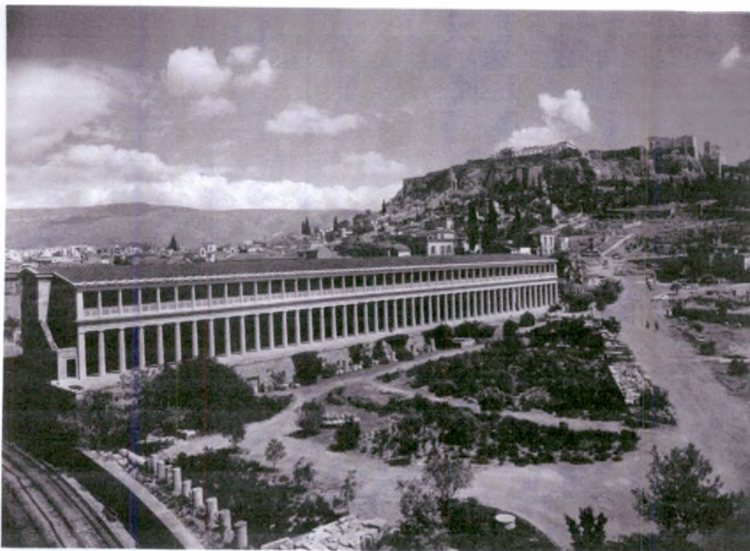
24. Στοά Αττάλου. Ανακατασκευή (από ΒΔ).
