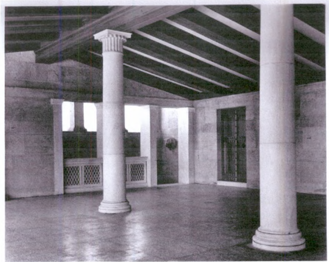
20. Η Στοά Αττάλου μετά την ανακατασκευή. Επάνω όροφος, βόρειο άκρο.
