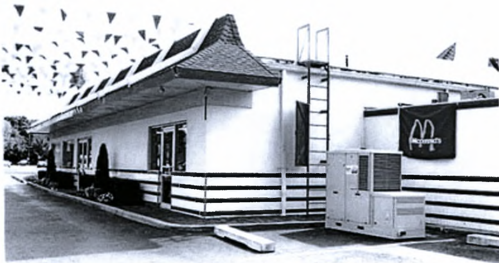
Σχήμα 2. 32 Το εστιατόριο McDonalds στη North Babylon (NY) τροφοδοτείται με ρεύμα σε ορισμένα τμήματα με ΗΣΚ.
