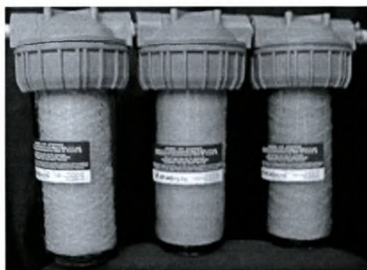
Σχήμα 3-18: Φίλτρα των 25 \mu\text{m} , 5 \mu\text{m} και 1-3 \mu\text{m}
