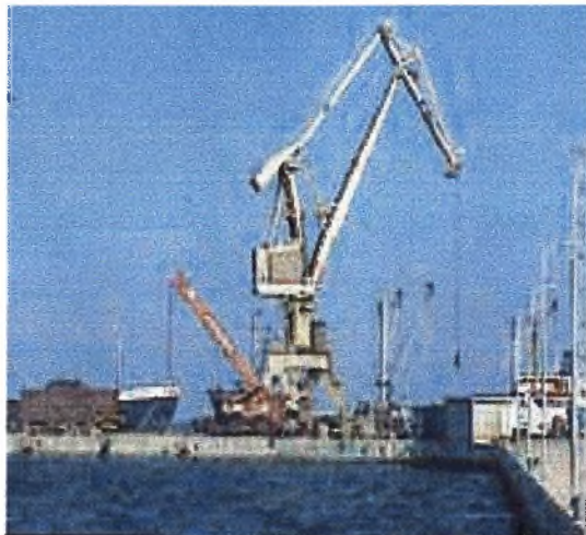
Εικόνα 13. Κρηπίδωμα στο εργοστάσιο SOVEL στον Αλμυρό
