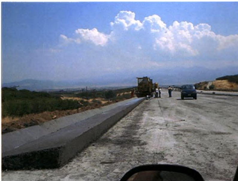
Φωτογραφία 29: Κατασκευή τάφρου
