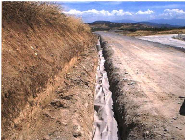
Φωτογραφία 27: Τοποθέτηση στραγγιστηρίων αγωγού
