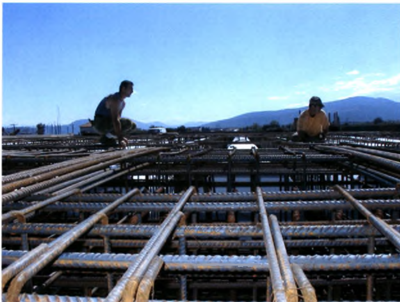
Φωτογραφία 7: Σιδηρούς οπλισμός πλάκας τεχνικού T1 Α.Κ. Αλμυρού
