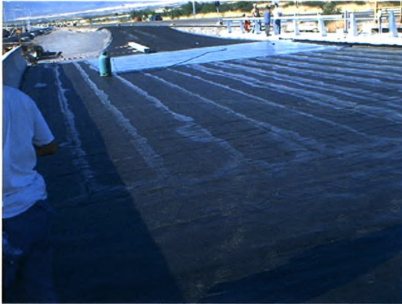
Φωτογραφία 13: Τοποθέτηση στεγανών μεμβρανών τεχνικού T7 Α.Κ. Μικροθηβών
