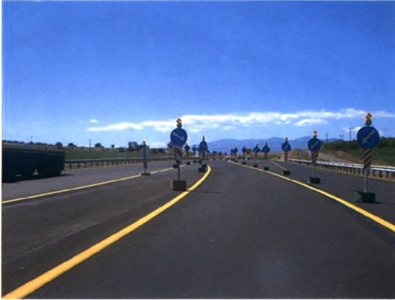
Φωτογραφία 18: Προσωρινή Σήμανση και Διαγράμμιση για εκτροπή κυκλοφορίας Α.Κ. Μικροθηβών
