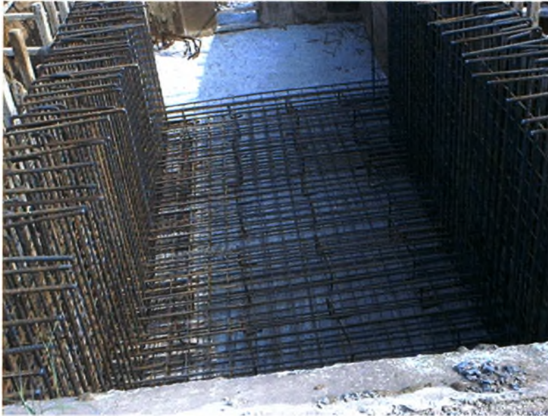
Φωτογραφία 6: Σιδηρούς οπλισμός μικρού τεχνικού
