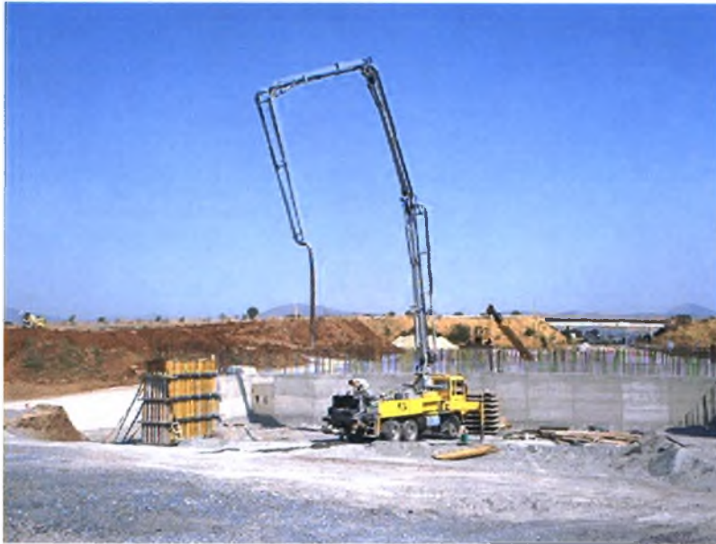
Φωτογραφία 11: Σκυροδέτηση μεγάλου τεχνικού T1 Α.Κ. Αλμυρού
