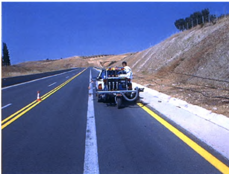
Φωτογραφία 20: Προσωρινή Διαγράμμιση για εκτροπή κυκλοφορίας Α.Κ. Μικροθηβών
