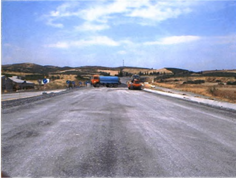
Φωτογραφία 16: Συμπύκνωση Υπόβασης αρτηρίας δεξιού κλάδου Α.Κ. Μικροθηβών
