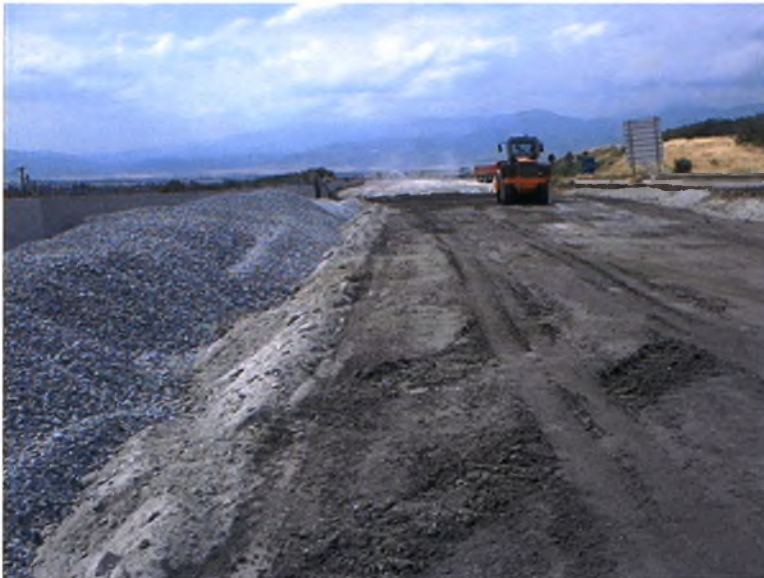
Φωτογραφία 5: Μεταβατικά επιχώματα Σύνθετου Τεχνικού Α.Κ. Μικροθηβών
