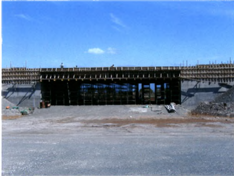
Φωτογραφία 9: Τοποθέτηση κριωμάτων και ξυλότυπου τεχνικού T1 Α.Κ. Αλμυρού
