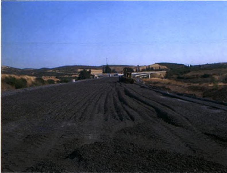
Φωτογραφία 15: Διάστρωση θραυστού υλικού E4 Α.Κ. Μικροθηβών
