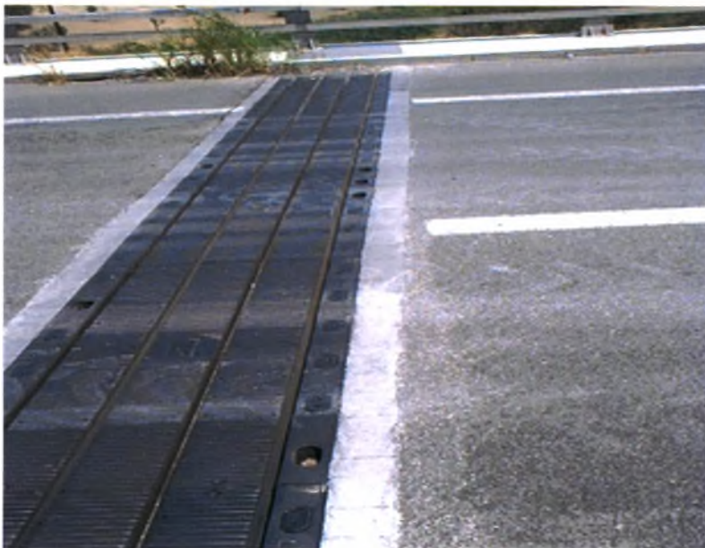
Φωτογραφία 14: Κατασκευή αρμού τεχνικού Α.Κ. Μικροθηβών
