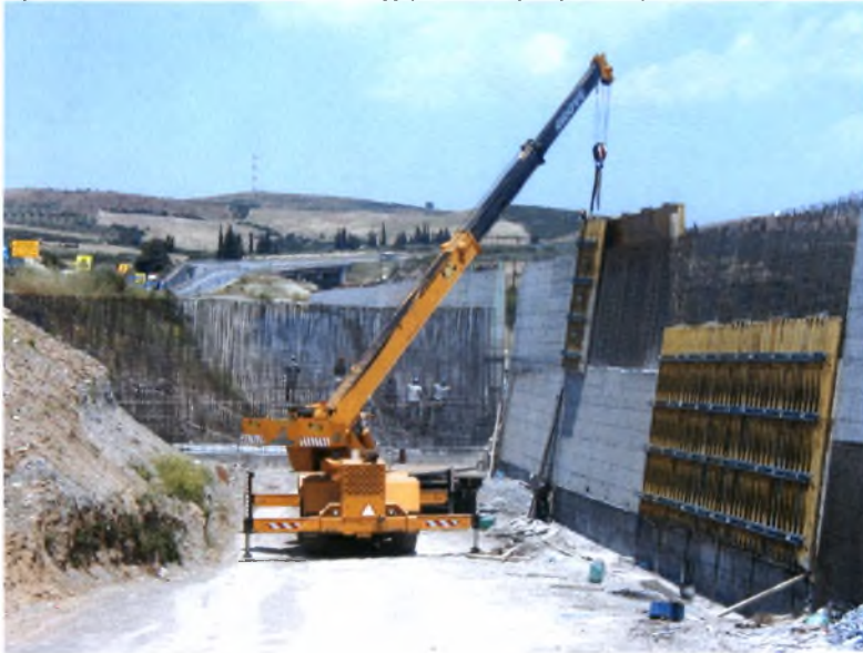
Φωτογραφία 8: Τοποθέτηση μεταλλότυπου Σύνθετου Τεχνικού Α.Κ. Μικροθηβών
