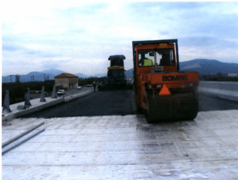
Φωτογραφία 24: Διάστρωση ασφαλτικής στρώσης
