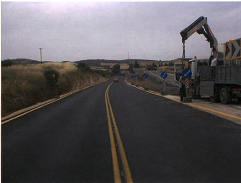
Φωτογραφία 19: Τοποθέτηση Προσωρινής Σήμανσης για εκτροπή κυκλοφορίας Α.Κ. Μικροθηβών
