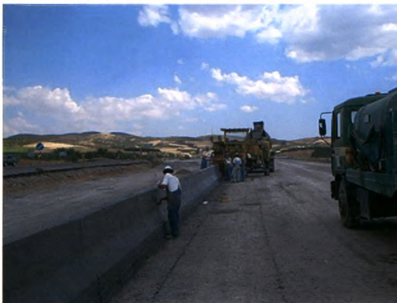
Φωτογραφία 23: Κατασκευή στηθαίων από σκυρόδεμα (N. Jersey)
