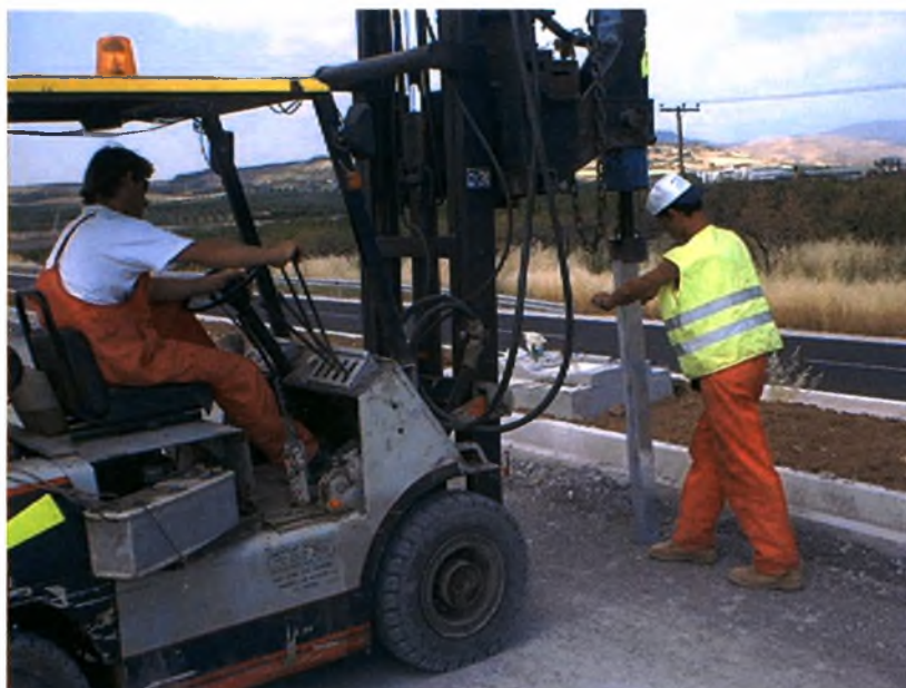
Φωτογραφία 22: Τοποθέτηση μεταλλικών στηθαίων
