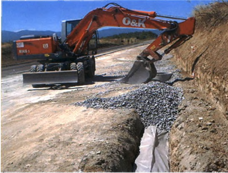
Φωτογραφία 28: Πλήρωση αγωγού με θραυστό υλικό
