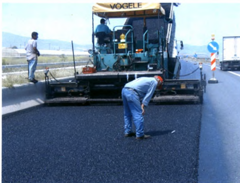
Φωτογραφία 25: Διάστρωση αντιολισθηρής ασφαλτικής στρώσης
