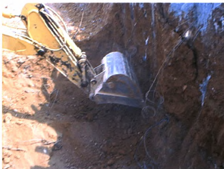
Φωτογραφία 3: Εκσκαφή θεμελίων τεχνικού έργου
