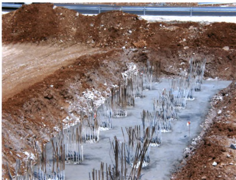
Φωτογραφία 10: Θεμελίωση μεγάλου τεχνικού T1 με πασσάλους Α.Κ. Αλμυρού
