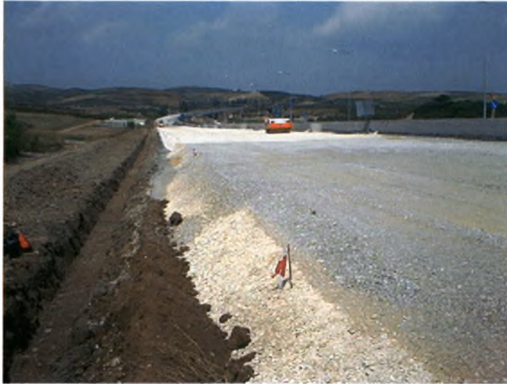
Φωτογραφία 17: Συμπύκνωση Βάσης αρτηρίας αριστερού κλάδου Α.Κ. Μικροθηβών
