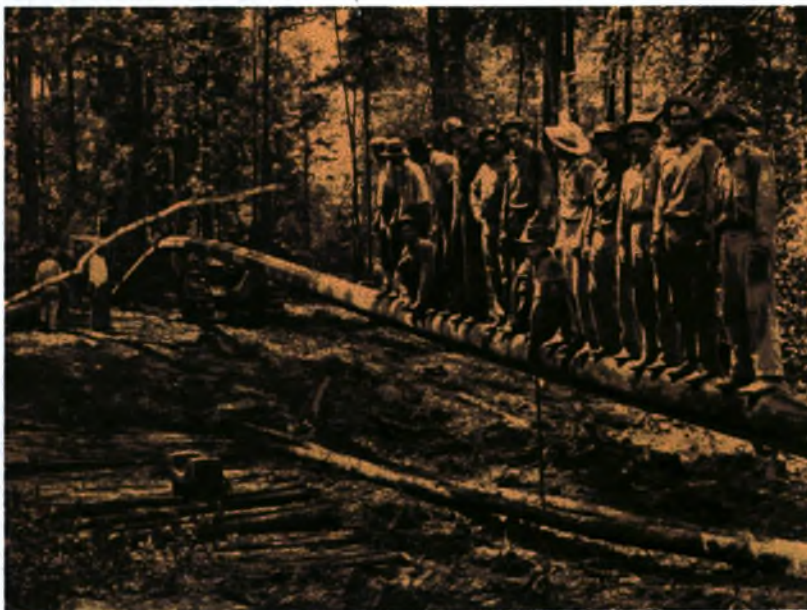
Σχήμα 1-4. Μια ιστορική φωτογραφία. “Εφαρμογή εγκάρσιας φόρτισης” στο ένα άκρο ανυψωμένου σωλήνα για την επίτευξη κάμψης (Max Hosmanek 1984).
