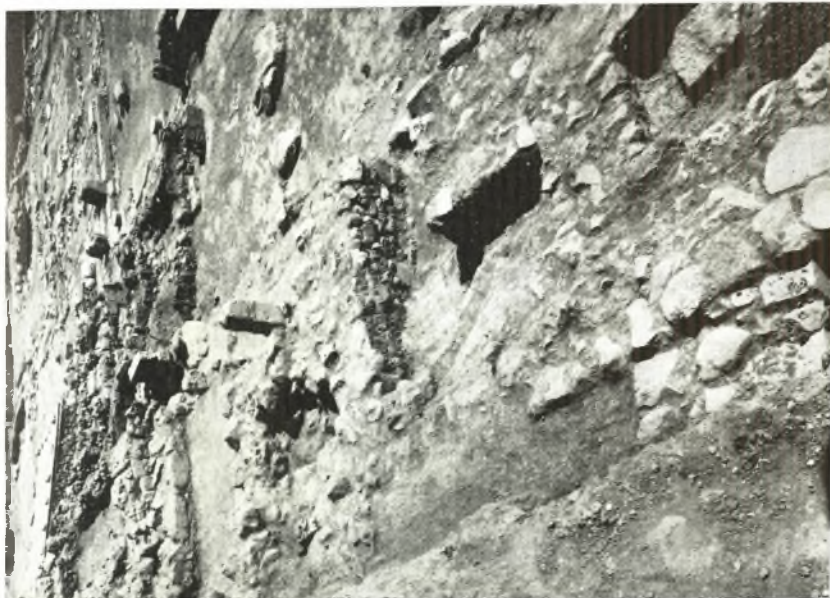
β. Γενική άποψη από Βορρά προς τὸ ἄνω τῶν διαμερισμάτων τοῦ μαγειρείου οἰκοδομικὸν συγκροτήμα. Εἰς τὸ βάθος ἡ ἀνατολική πτέρυξ τοῦ ἀνακτόρου.
