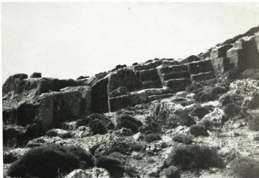
α. Τὸ εἰς θέσιν Πελεκητὰ μινωικὸν λατομεῖον πωρολίθου, μὲ χαρακτηριστικούς ἀναβαθμοὺς κοπῆς τοῦ ὕλικου.
