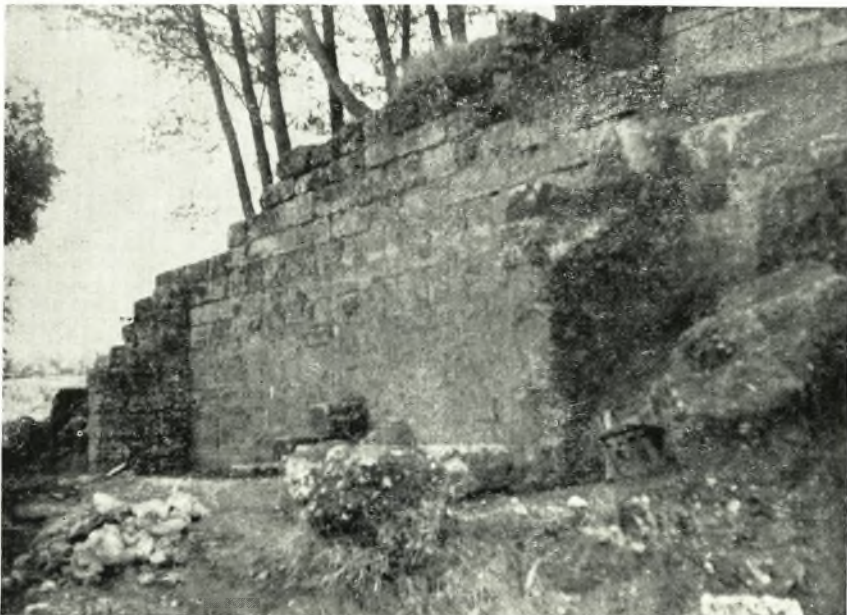
β. Ὁ μετ' ἀντερεισμάτων ἀναλημματικὸς τοῖχος τῆς βορείου παρόδου τοῦ θεάτρου τῆς Μεγαλοπόλεως.
