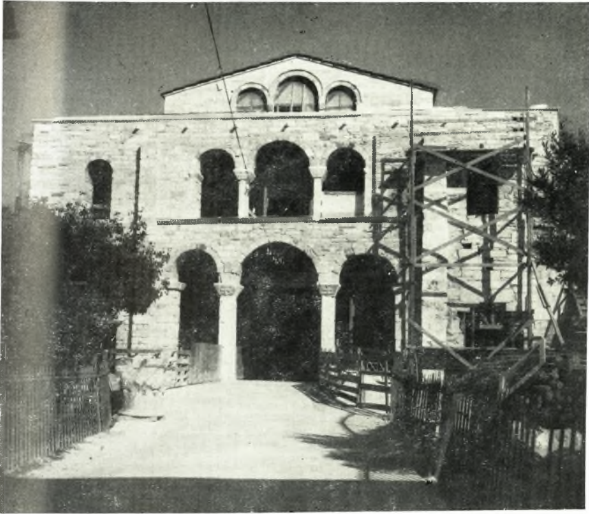
α. Ἀποψις τῆς προσόψεως τοῦ ναοῦ τῆς Καταπολιανῆς μετὰ τὰς ἐργασίας ἀναστηλώσεως αὐτῆς.
