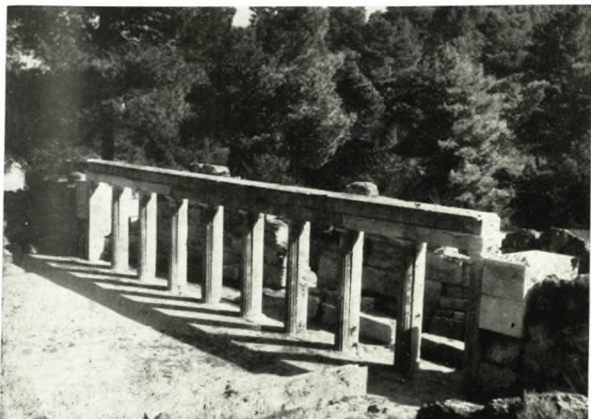
β. Ἡ δλοσχερῶς ἀναστηλωθεῖσα κιονοστοιχία τοῦ προσκηνίου τοῦ ἐν Ἀμφιαρείῳ τοῦ Ὀρωποῦ θεάτρου.
