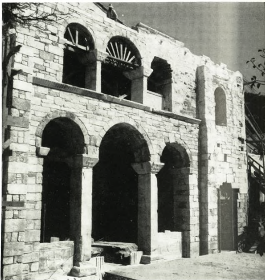
Τὸ τρίβηλον τοῦ ἰσογείου καὶ τὸ τρίλοβον παράθυρον τοῦ γυναικωνίτου τῆς Καταπολιανῆς ὡς ἀπεκαλύφθησαν διὰ τῶν ἐργασιῶν ἀναστηλώσεως αὐτῆς.
